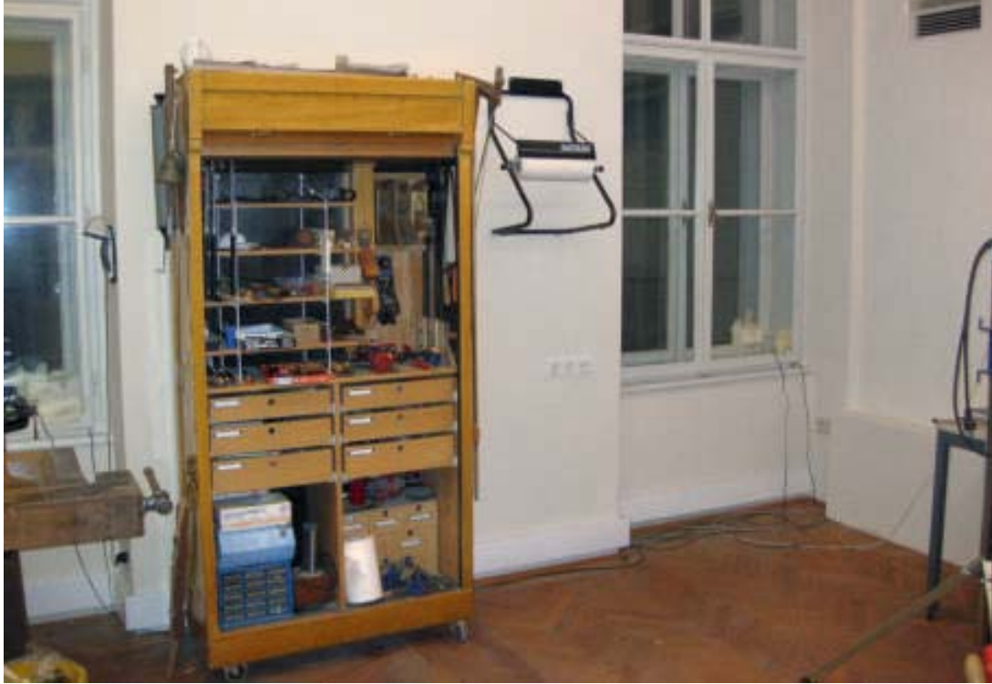
Abb. 11 a: Anstelle der Radiatoren wurde in der oberen Werkstatt die Sockelheizleiste entlang der Außenwand verlegt.
