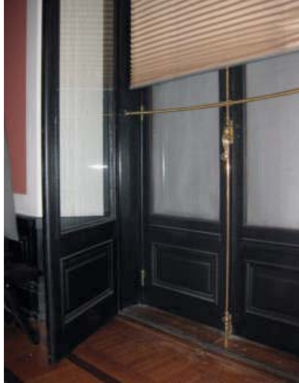
Abb. 1: Türe in Saal 3 der Hofjagd- und Rüstkammer mit Vorsatzflügel, Stockleisten und Winddruckbogen.
