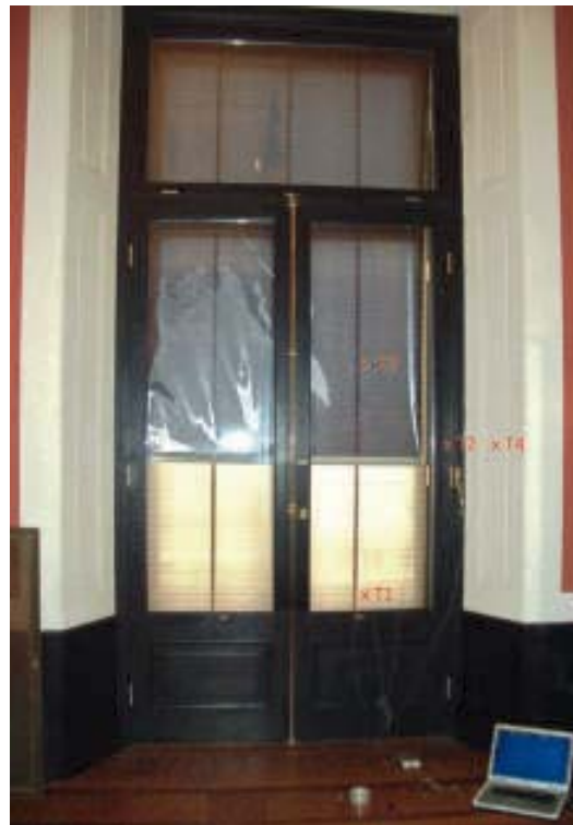
Abb. 4: Türelement im Saal 3 mit der Anordnung der Thermo-elemente.
