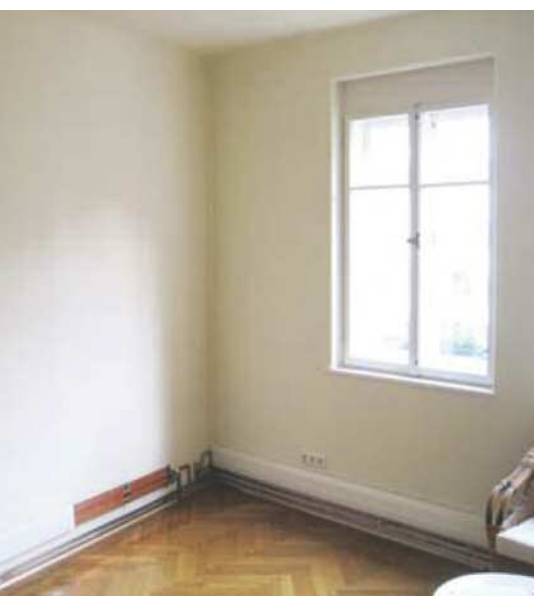
Das sanierte Arbeitszimmer mit Sockelheizleiste und Linearheizkörper in der Außenwanddecke
